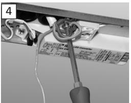
Schließen Sie die Netzleitungen an die Klemmen L und N und den Schutzleiter an die Erdschraubklemme an
