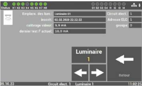
Fig. 54: État d'un luminaire
