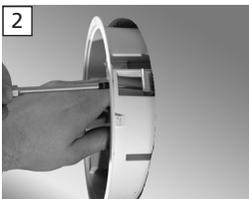
Führen Sie die Netzleitungen in das Leuchtengehäuse und setzen es in die Wand ein. Befestigen Sie das Gehäuse durch Anziehen der Befestigungskrallen-Schrauben. Achten Sie darauf, dass die Einführungsstülsen **horizontal** unten am Gehäuse verlaufen! (s. roten Aufkleber in Leuchte).
